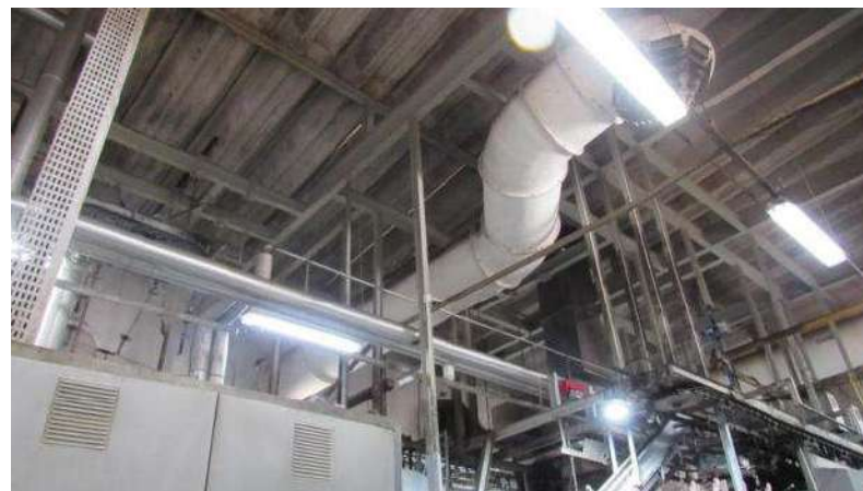
BLOCO INDUSTRIAL Aspecto Interno
