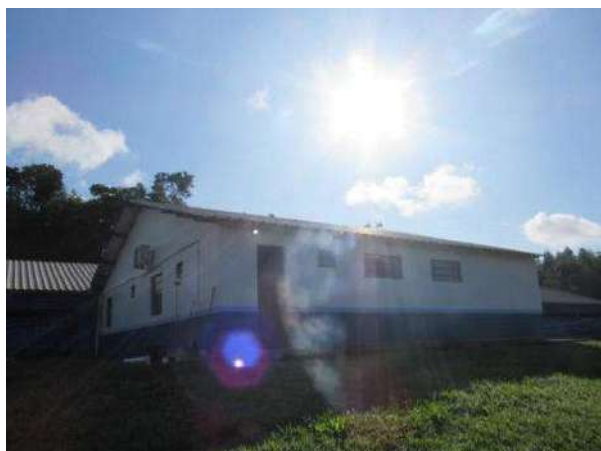
LABORATÓRIO Aspecto Externo
