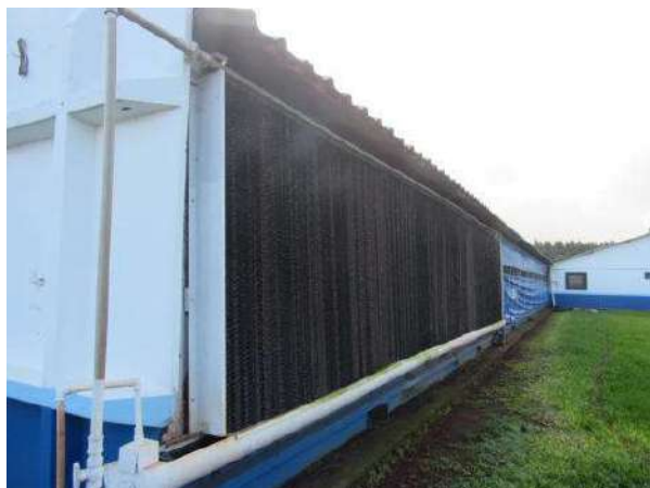
NR 999 - PLACA EVAPORATIVA / COLMÉIA DIM. 7 X 2 M
