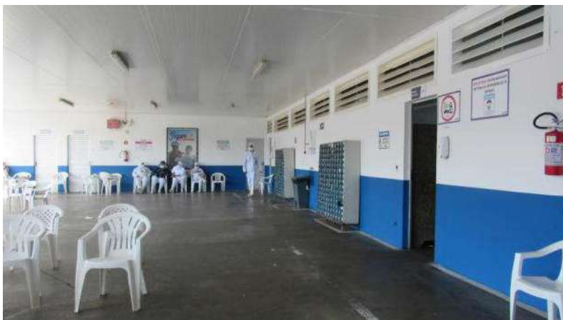
VESTIÁRIOS E OUTROS Aspecto Interno
