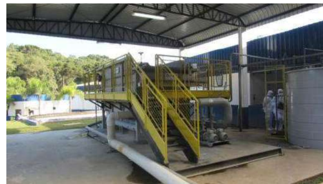
COBERTURA FLOTADOR / MISTURADOR 2 Aspecto Geral
