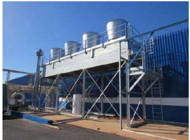
NR 104426 - AEROCONDENSADOR CAP. 6000 L/H THOR
