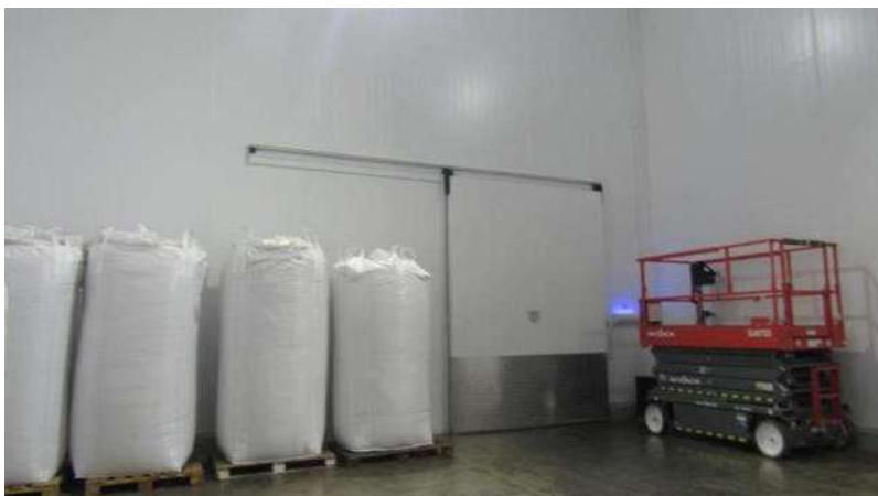
FÁBRICA DE BANHA Aspecto Interno
