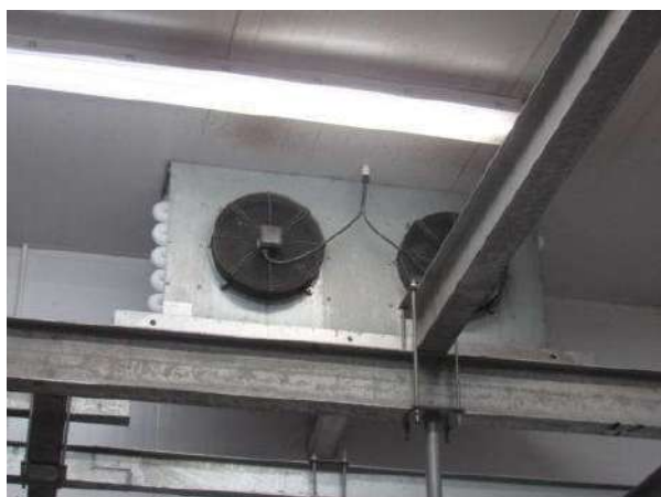
NR 999 - EVAPORADOR COM 2 VENTILADORES EXPEDIÇÃO VAREJO NICOLA
