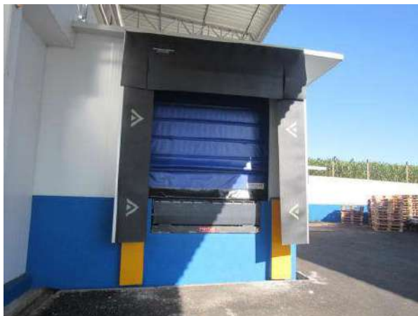
NR 106231 - DOCA NIVELADORA COM PORTA AUTOMÁTICA RAYFLEX
