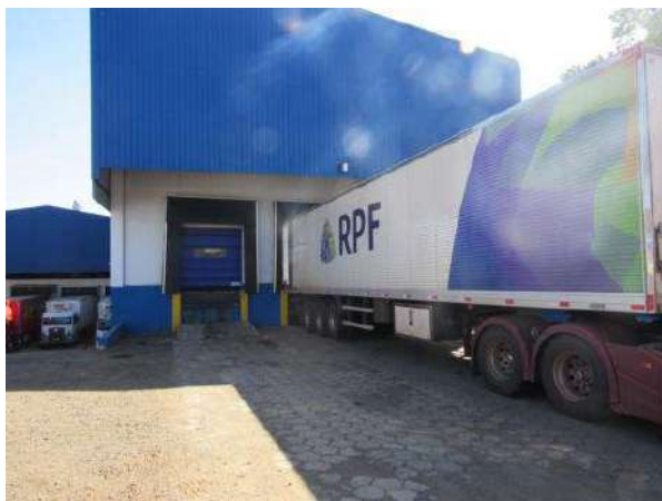
NR 999 - DOCA NIVELADORA COM PORTA AUTOMÁTICA RAYFLEX
