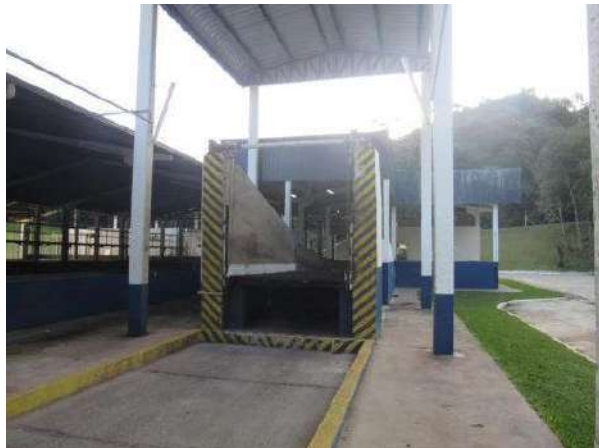
NR 999 - RAMPA DE DESCARREGAMENTO
