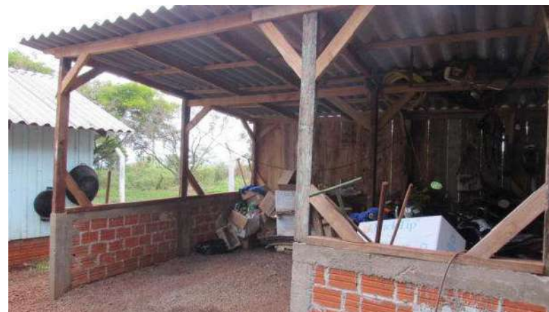
DEPÓSITO DE ALVENARIA Aspecto Interno
