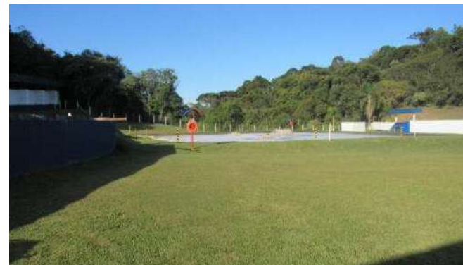
LAGOA DE TRATAMENTO COM LONA Aspecto Geral
