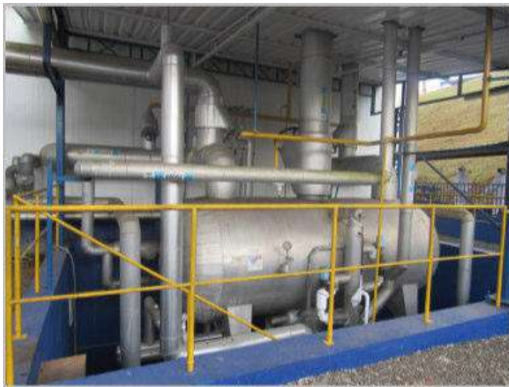
- RESERVATÓRIO DE AMÔNIA CAP. 15 M 3
