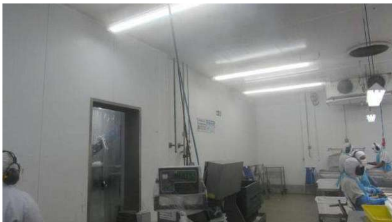
BLOCO INDUSTRIAL Aspecto Interno
