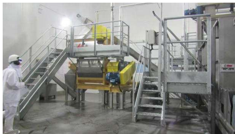
FÁBRICA DE BANHA Aspecto Interno
