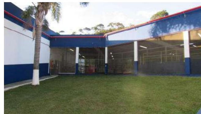
PINTURAS E REFORMAS Aspecto Geral
