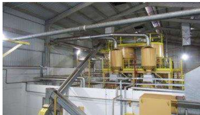
GRAXARIA Aspecto Interno
