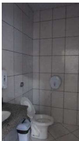
AMPLIAÇÃO DIF Aspecto Interno
