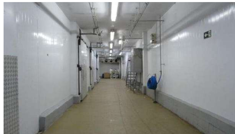
DESOSSA E TÚNEL Aspecto Interno
