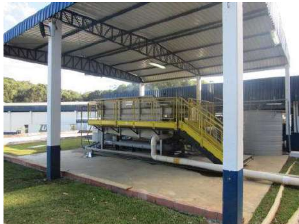
NR 999 - FLOTADOR CAP. 8000 L / 50 M 3 /H GRATT
