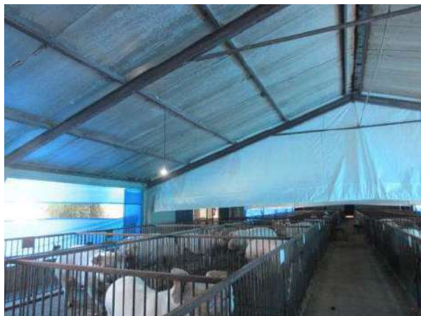
GALPÃO DE REPRODUTORES Aspecto Interno
