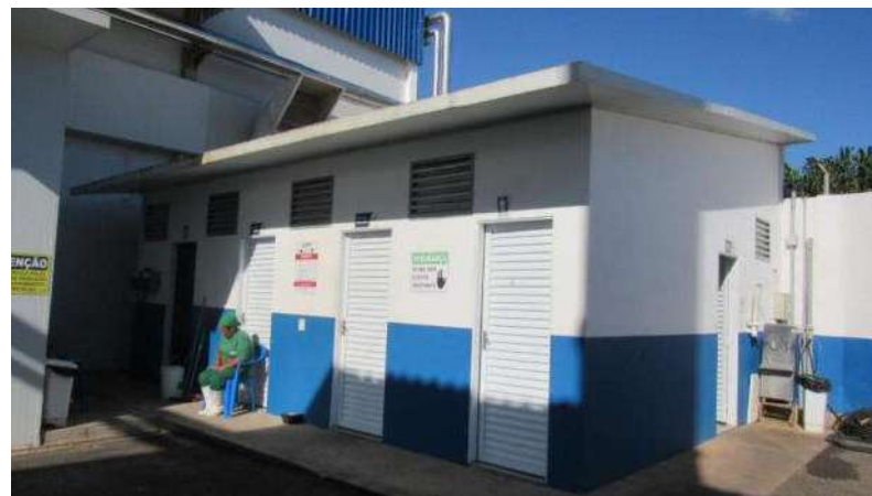
VESTIÁRIO E WC Aspecto Geral
