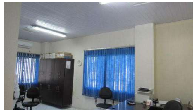
AMPLIAÇÃO DIF Aspecto Interno
