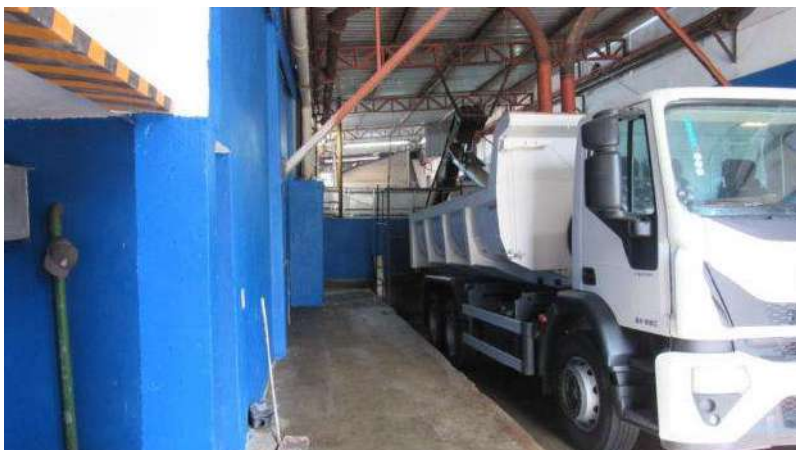
BLOCO INDUSTRIAL (RESÍDUOS) Aspecto Geral
