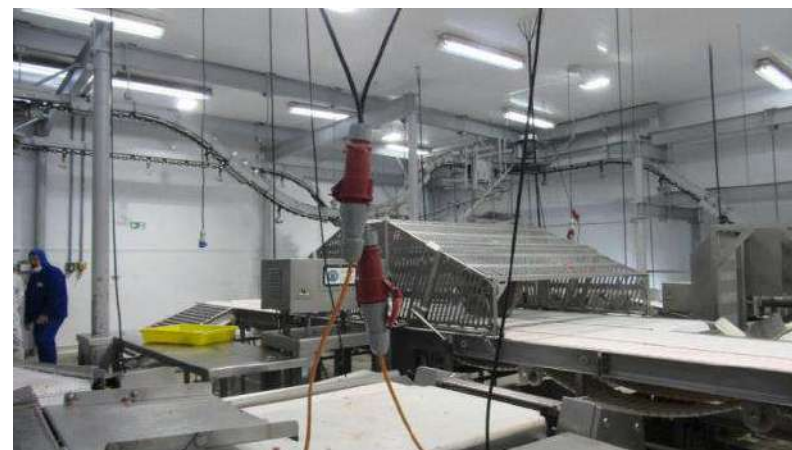
DESOSSA E TÚNEL Aspecto Interno
