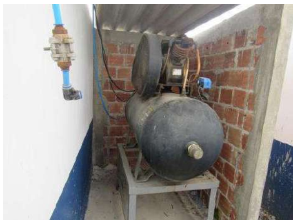
NR 999 - COMPRESSOR DE PISTÃO 1 CABEÇOTE 2 CILINDROS SCHULZ
