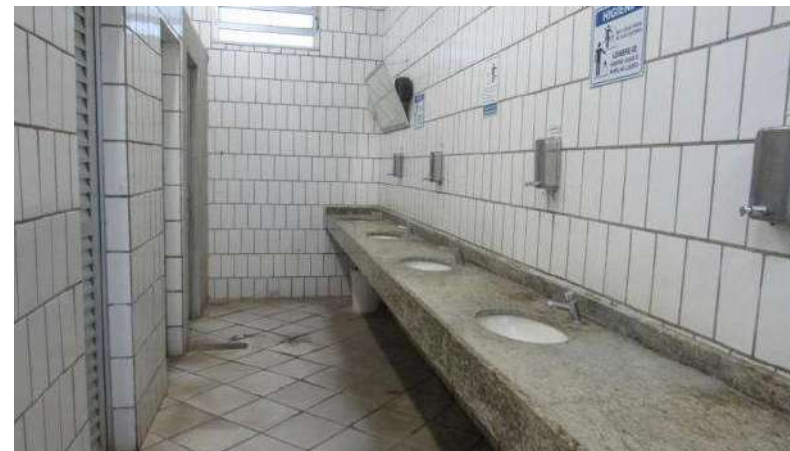
CONTROLE DE QUALIDADE E SANITÁRIOS Aspecto Interno
