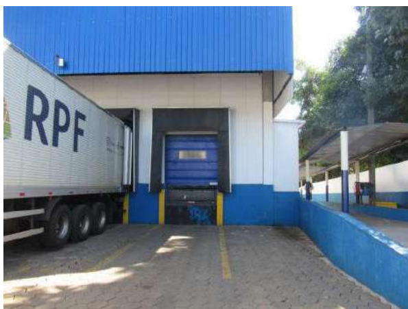
NR 999 - DOCA NIVELADORA COM PORTA AUTOMÁTICA RAYFLEX
