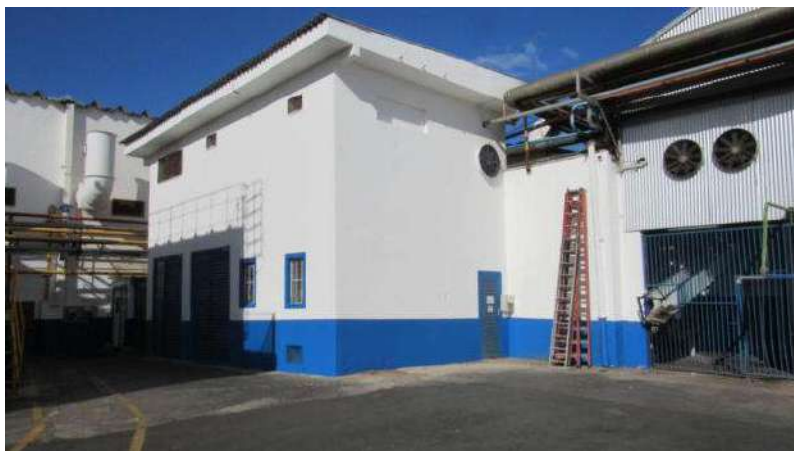
DESOSSA E TÚNEL Aspecto Externo
