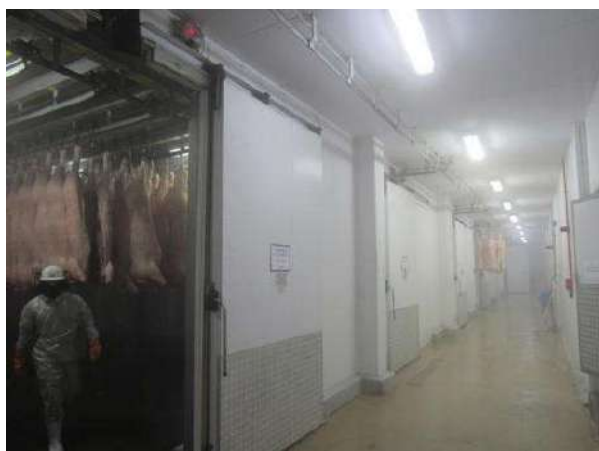
NR 999 - CÂMARA FRIA RESFRIAMENTO CARÇAÇA 3,85 x 17 x 5,1 M - 7
