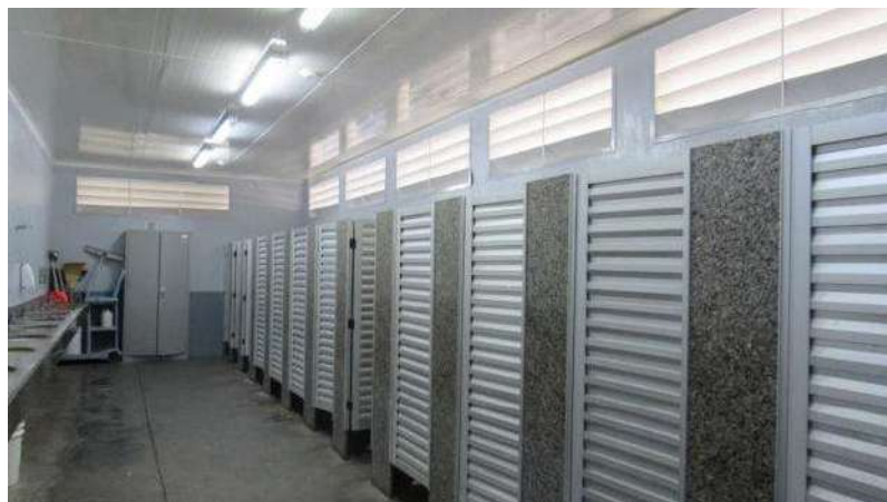
VESTIÁRIOS E OUTROS Aspecto Interno
