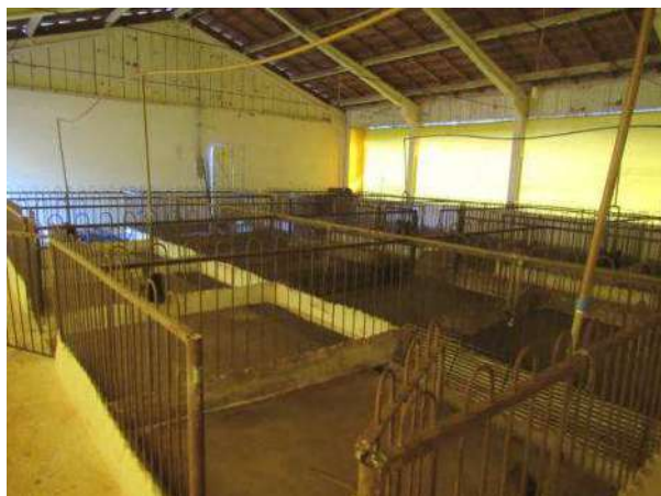
GALPÃO DESATIVADO Aspecto Interno
