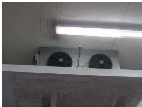
NR 999 - EVAPORADOR COM 2 VENTILADORES EXPEDIÇÃO VAREJO
