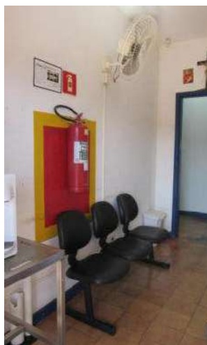
ADMINISTRATIVO Aspecto Interno
