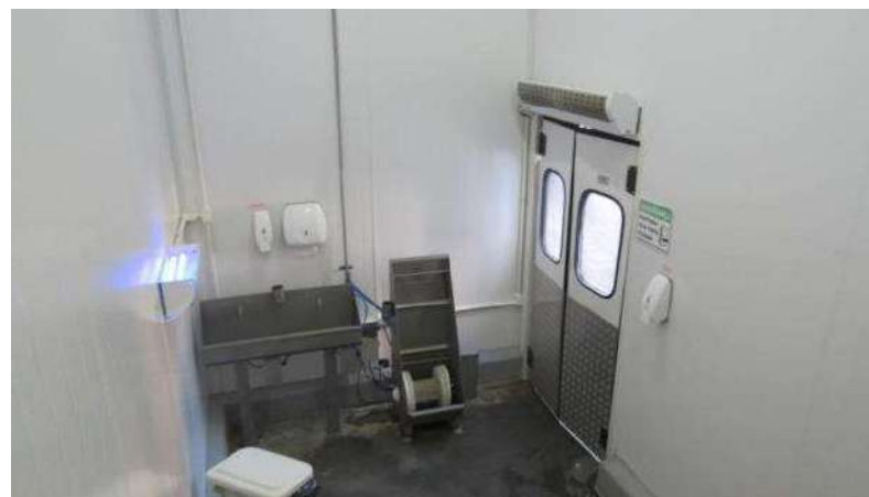
FÁBRICA DE BANHA Aspecto Interno
