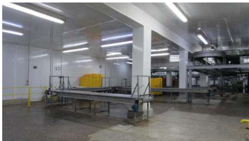
DESOSSA E TÚNEL Aspecto Interno
