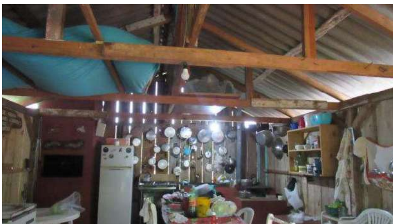
RANCHO Aspecto Interno
