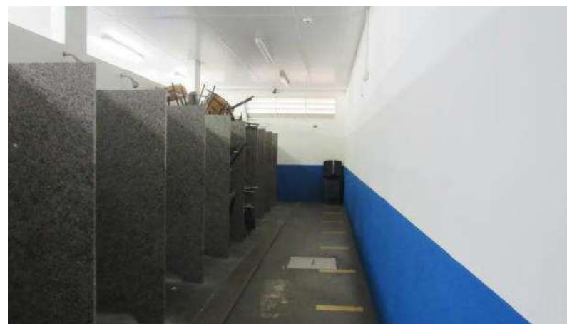
VESTIÁRIOS E OUTROS Aspecto Interno
