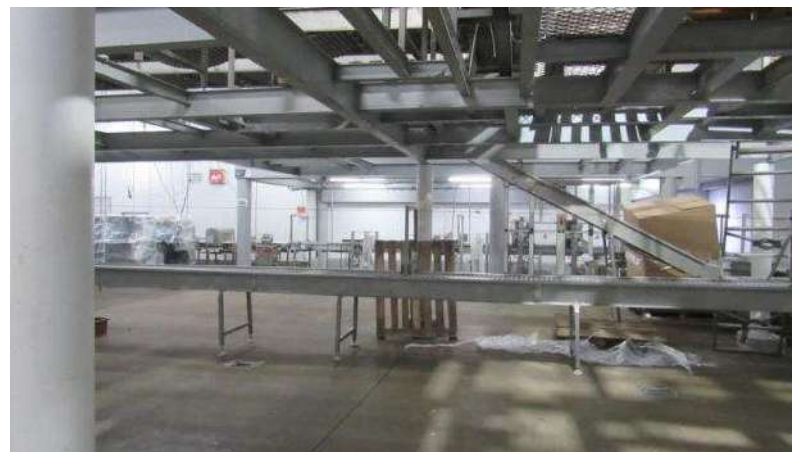
BLOCO INDUSTRIAL Aspecto Interno
