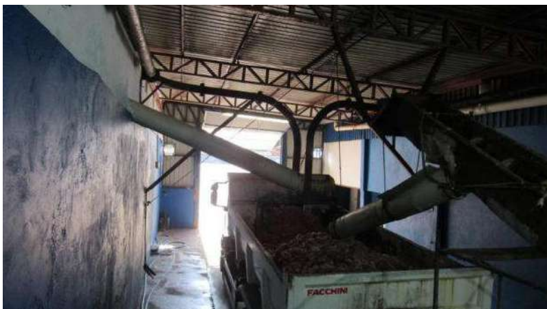
BLOCO INDUSTRIAL (RESÍDUOS) Aspecto Geral
