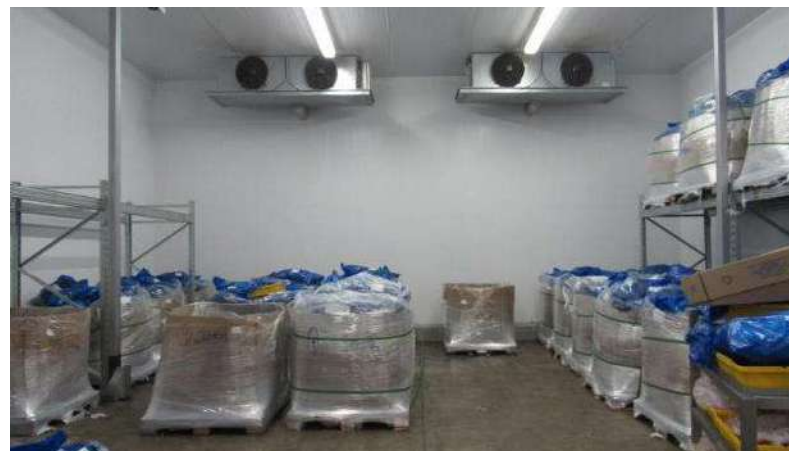
DESOSSA E TÚNEL Aspecto Interno
