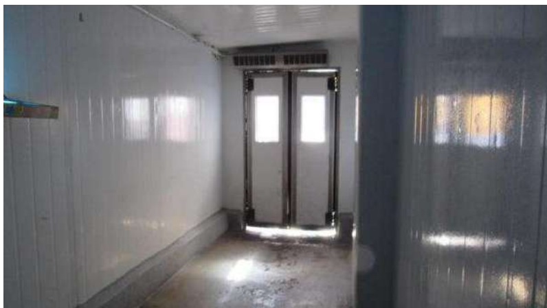
BLOCO INDUSTRIAL Aspecto Interno
