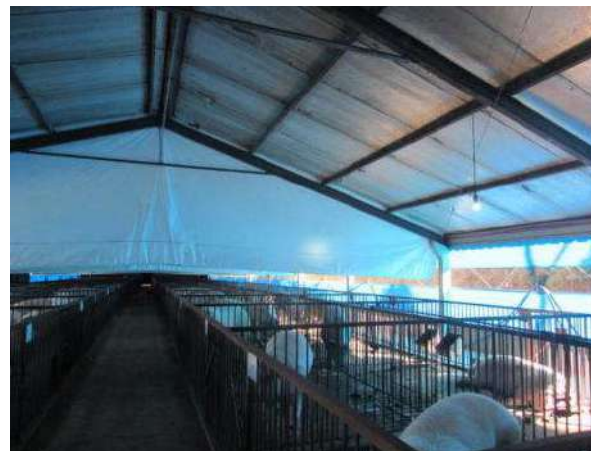
GALPÃO DE REPRODUTORES Aspecto Interno
