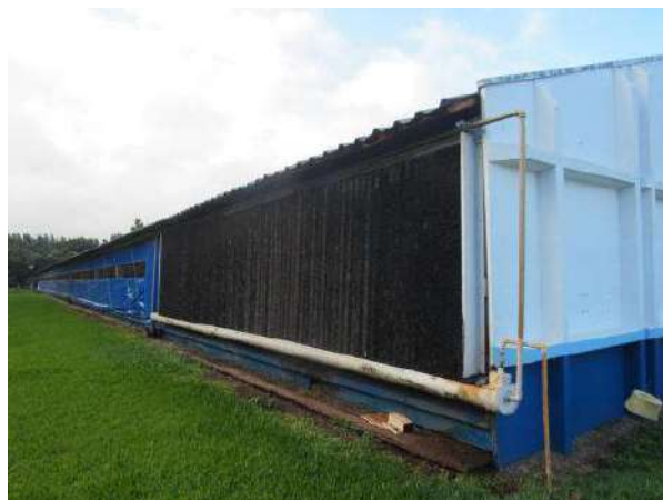
NR 999 - PLACA EVAPORATIVA / COLMÉIA DIM. 7 X 2 M
