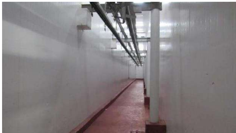
DESOSSA E TÚNEL Aspecto Interno
