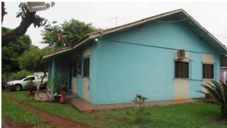
CASA DE ALVENARIA Aspecto Externo
