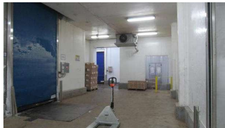
DESOSSA E TÚNEL Aspecto Interno
