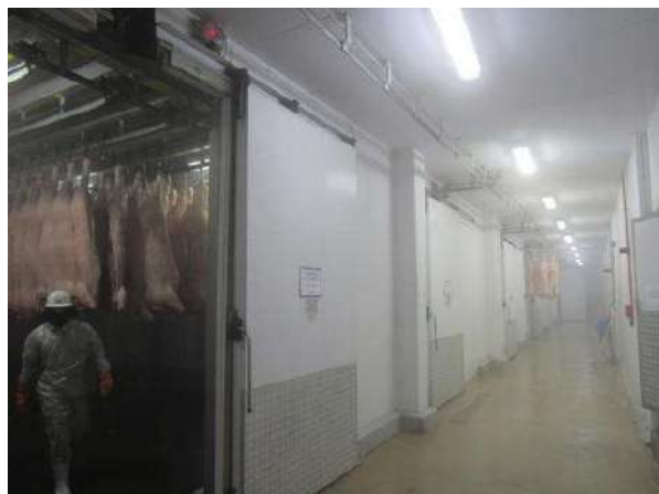
NR 999 - CÂMARA FRIA RESFRIAMENTO CARÇAÇA 6 x 14,3 5,1 M - 3
