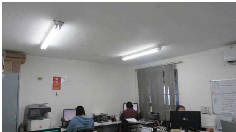
CONTROLE DE QUALIDADE E SANITÁRIOS Aspecto Interno
