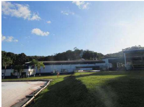
NR 999 - CLIMATIZAÇÃO DO FRIGORÍFICO DE BOCAIUVA (7 UN EXAUSTOR DE TELHADO ETM 900-1, 4 UN EXAUSTOR
