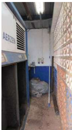
LAGOA DE TRATAMENTO AERÓBIA Aspecto Interno
