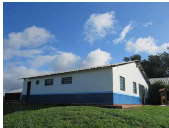
LABORATÓRIO Aspecto Externo
