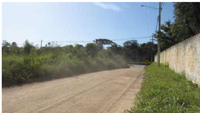
ACESSO Marginal rodovia BR 277
