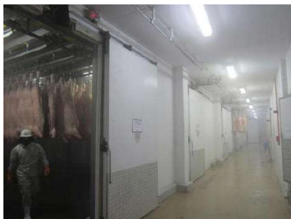
NR 999 - CÂMARA FRIA RESFRIAMENTO CARÇAÇA SEQUESTRO 3 x 10,5 x 5 M
