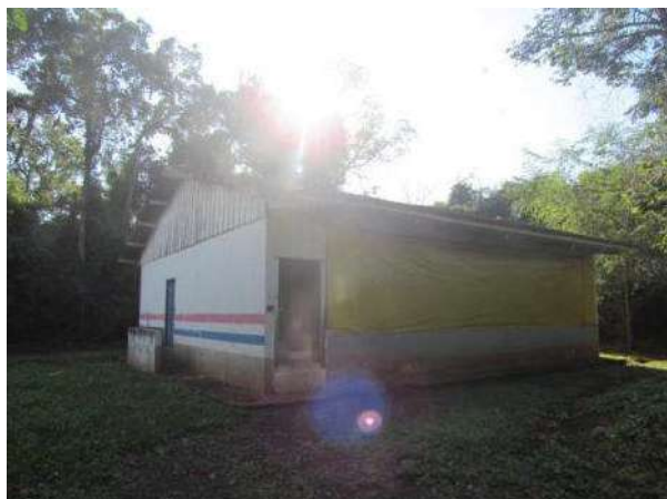
GALPÃO DESATIVADO Aspecto Externo
