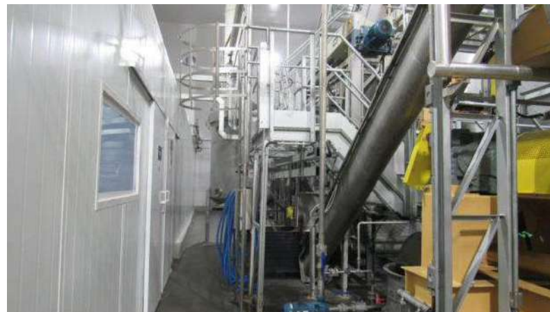
FÁBRICA DE BANHA Aspecto Interno
