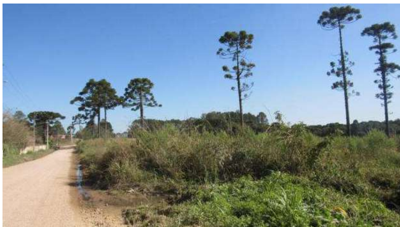
ACESSO Marginal rodovia BR 277
