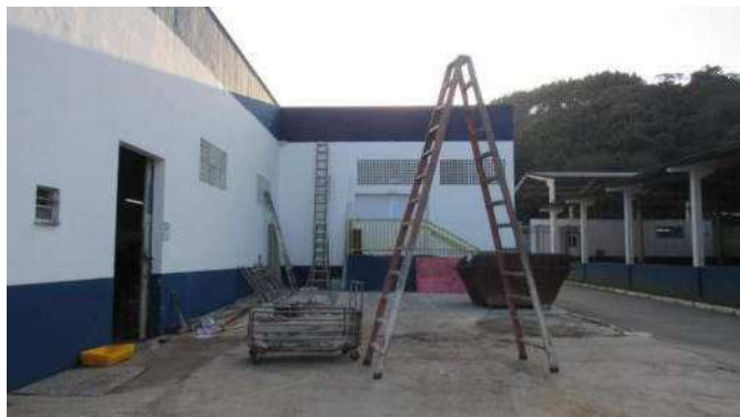
PINTURAS E REFORMAS Aspecto Geral
