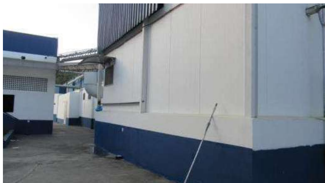
PINTURAS E REFORMAS Aspecto Geral
