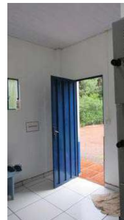
VESTIÁRIO Aspecto Interno
