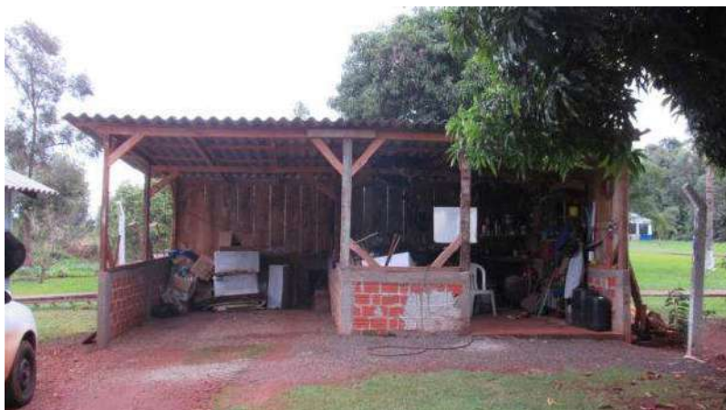
DEPÓSITO DE ALVENARIA Aspecto Externo
