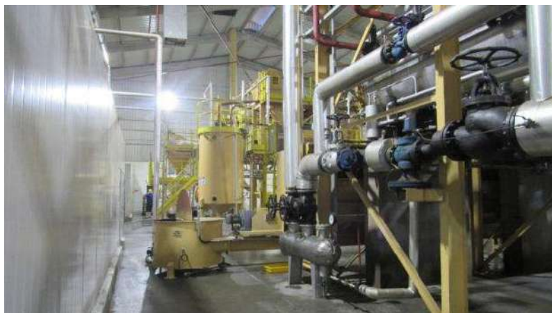
GRAXARIA Aspecto Interno
