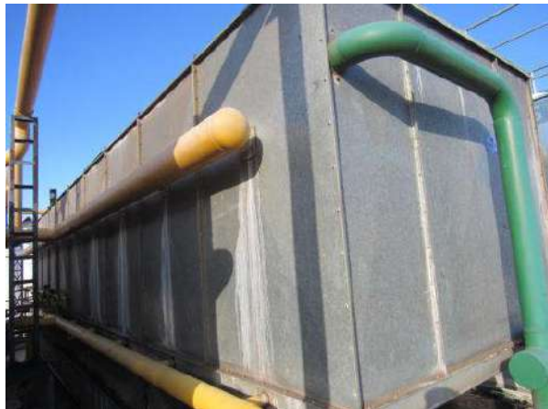
NR 999 - CONDENSADOR EVAPORATIVO
