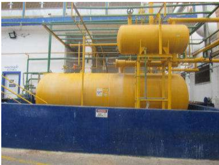
- RESERVATÓRIO DE AMÔNIA CAP. 15 M 3
