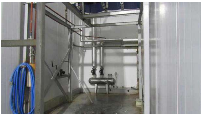
FÁBRICA DE BANHA Aspecto Interno
