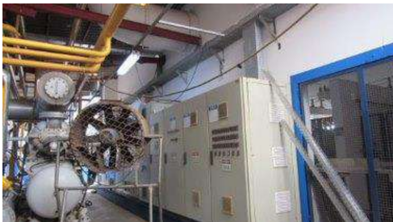
BLOCO INDUSTRIAL Aspecto Interno
