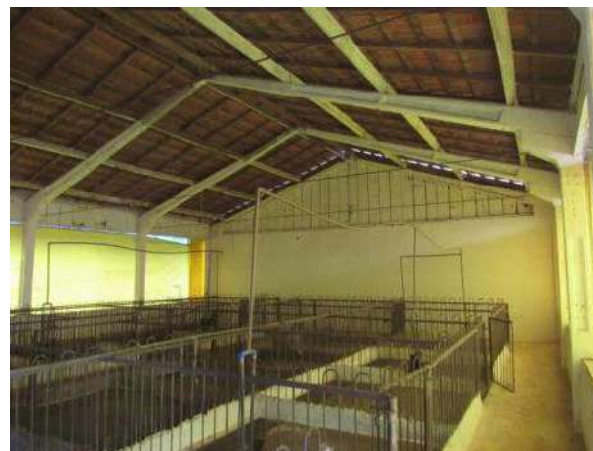
GALPÃO DESATIVADO Aspecto Interno
