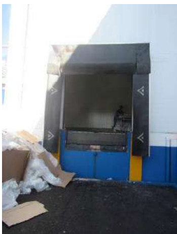
NR 106232 - DOCA NIVELADORA COM PORTA AUTOMÁTICA RAYFLEX
