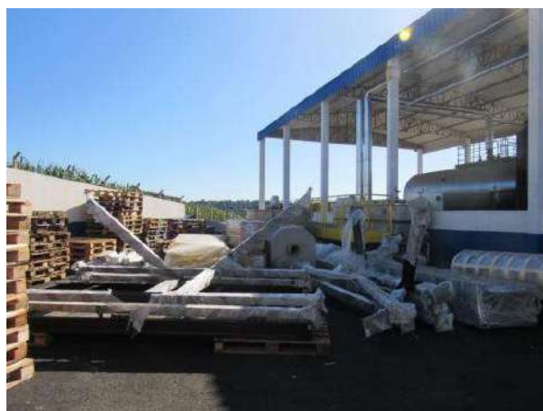
NR 999 - EQUIPAMENTOS ETE IBIPORÃ (NF 28203) GRATT
