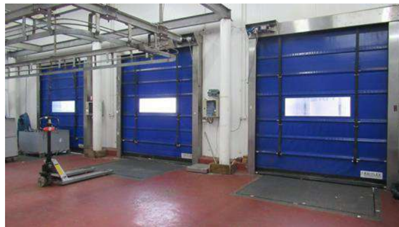
CÂMARA DE ESTOCAGEM Aspecto Interno
