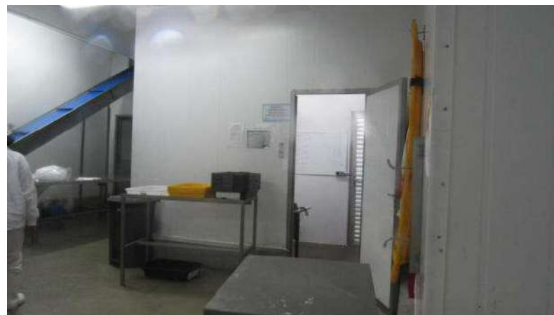
BLOCO INDUSTRIAL Aspecto Interno
