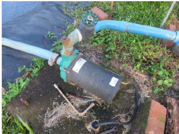
NR 999 - MOTOBOMBA DA ESTERQUEIRA POT. 3 CV ELETROPLAS
