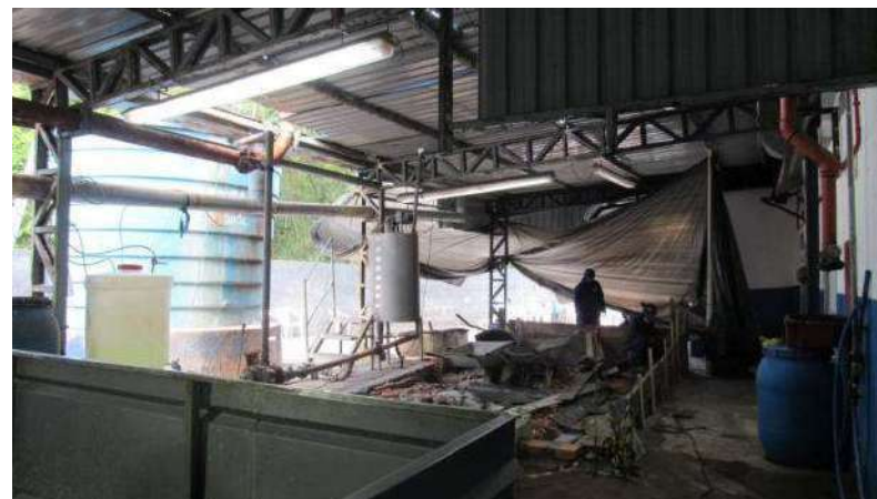
BLOCO INDUSTRIAL (RESÍDUOS) Aspecto Geral
