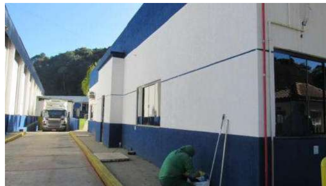
AMPLIAÇÃO DIF Aspecto Externo
