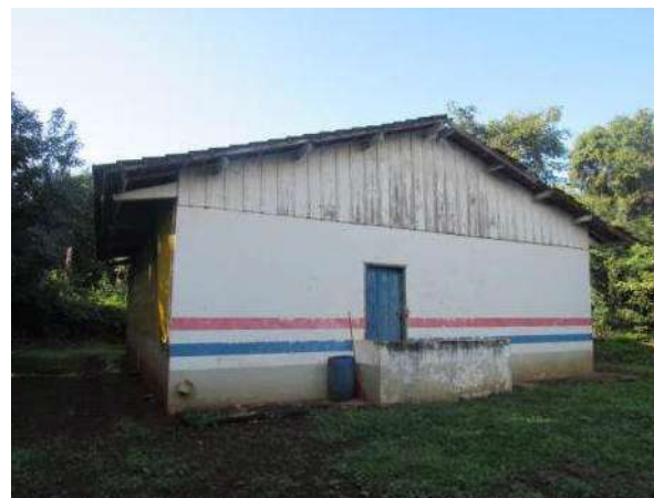
GALPÃO DESATIVADO Aspecto Externo
