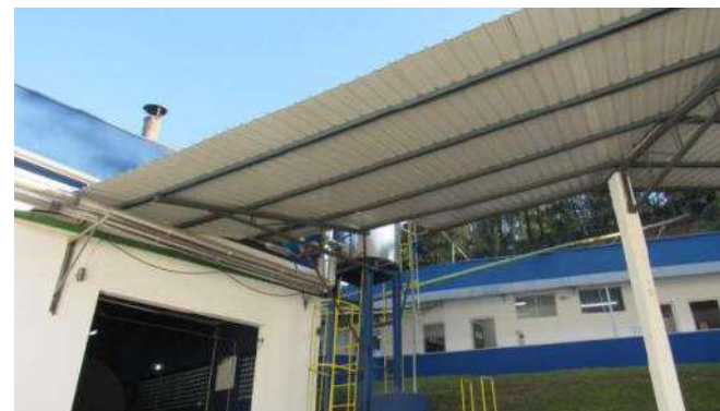
COBERTURA LENHA Aspecto Geral
