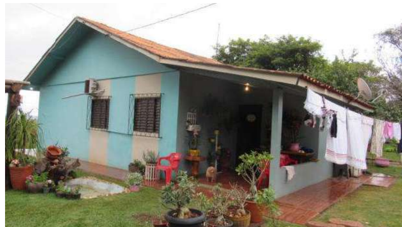
CASA DE ALVENARIA Aspecto Externo
