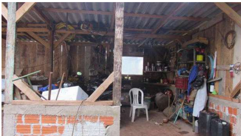
DEPÓSITO DE ALVENARIA Aspecto Interno
