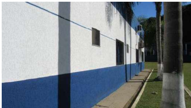
AMPLIAÇÃO DIF Aspecto Externo
