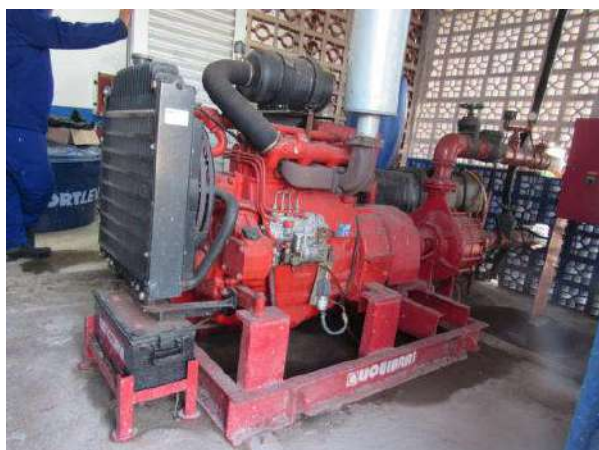
NR 999 - MOTOBOMBA DE INCÊNCIO DIESEL LIQUIBRAS/ THEBE / MWM
