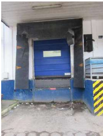
NR 999 - DOCA NIVELADORA COM PORTA AUTOMÁTICA RAYFLEX
