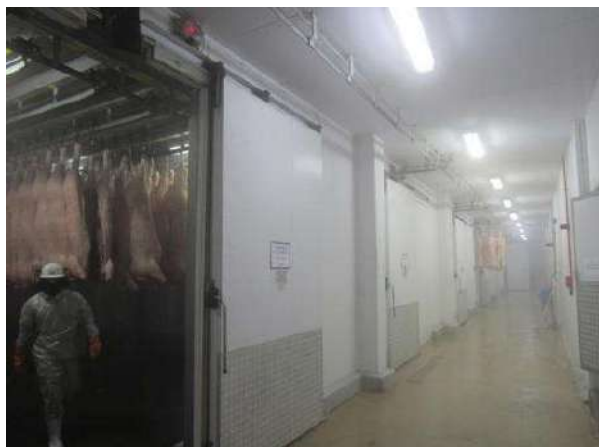
NR 999 - CÂMARA FRIA RESFRIAMENTO CARÇAÇA 5,86 x 14,3 x 5,1 M - 2
