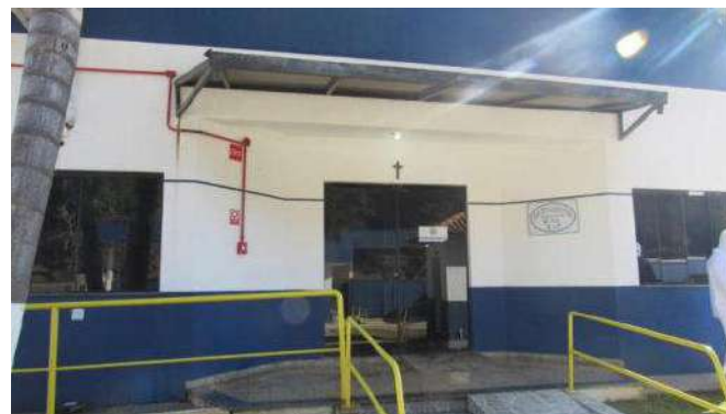
AMPLIAÇÃO DIF Aspecto Externo
