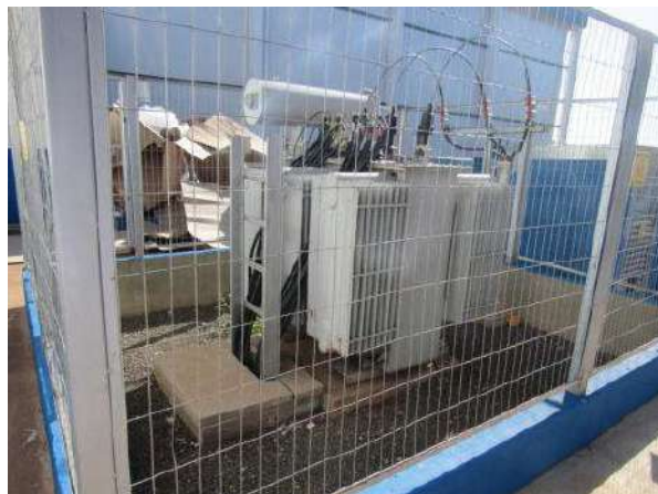
NR 999 - TRANSFORMADOR ÓLEO CAP. 750 KVA TRANSFORMADORES UNIÃO
