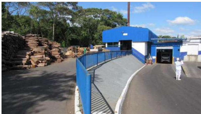
CALDEIRA (ÁREA INDUSTRIAL) Aspecto Geral
