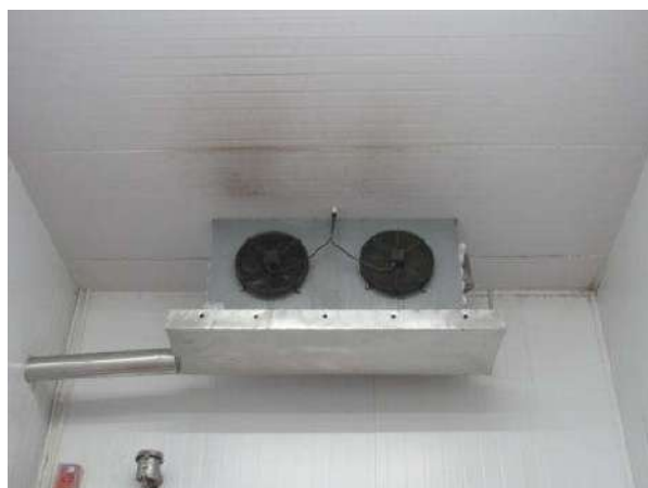
NR 999 - EVAPORADOR COM 2 VENTILADORES EXPEDIÇÃO VAREJO NICOLA
