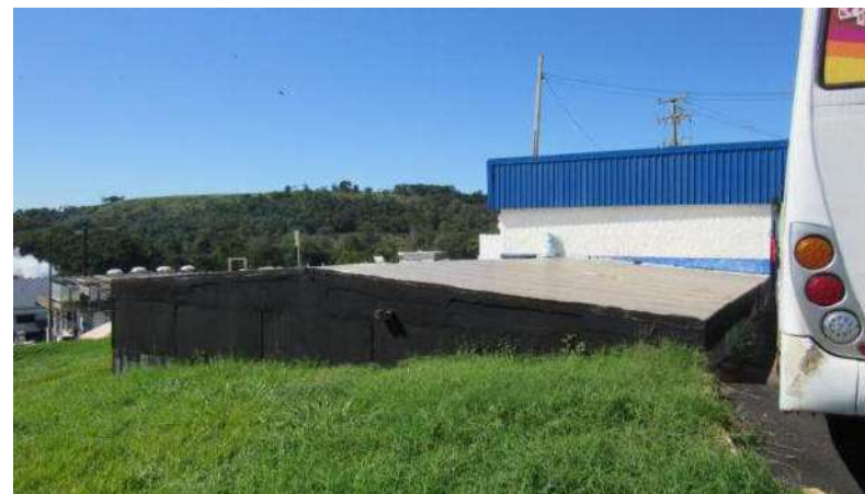
RESERVATÓRIO 600.000 L Aspecto Geral
