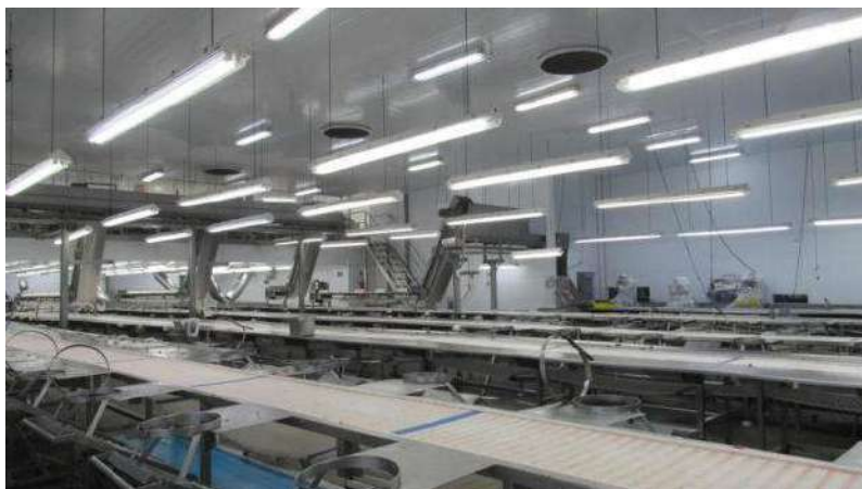
DESOSSA E TÚNEL Aspecto Interno
