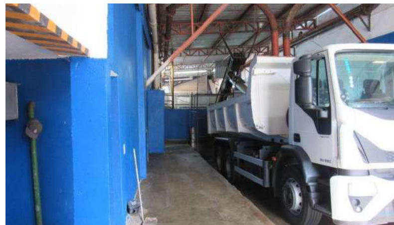
BLOCO INDUSTRIAL (RESÍDUOS) Aspecto Geral
