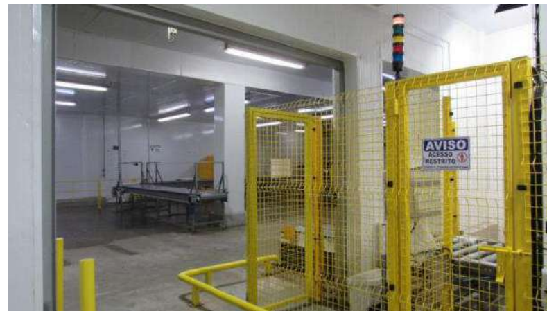
DESOSSA E TÚNEL Aspecto Interno
