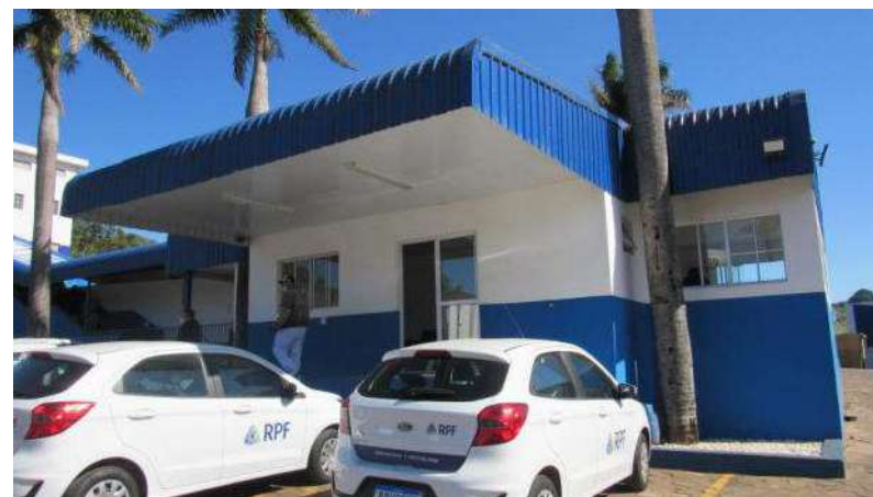
GUARITA Aspecto Externo
