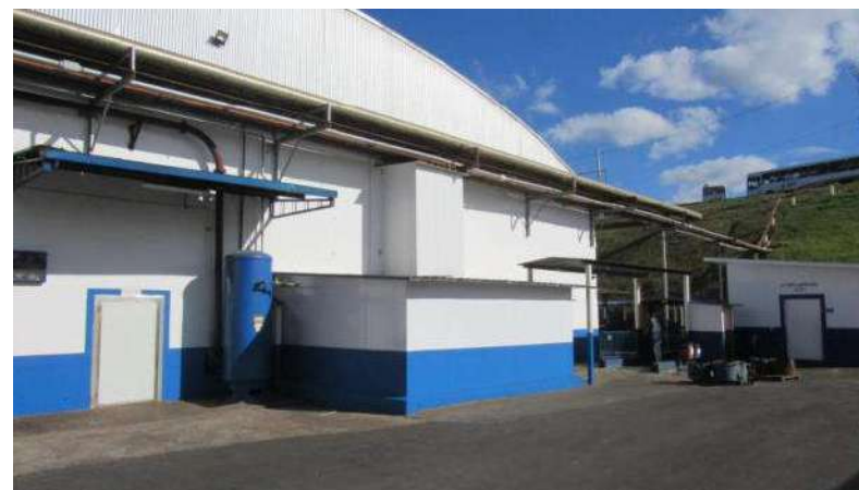
DESOSSA E TÚNEL Aspecto Externo
