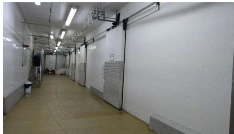
DESOSSA E TÚNEL Aspecto Interno
