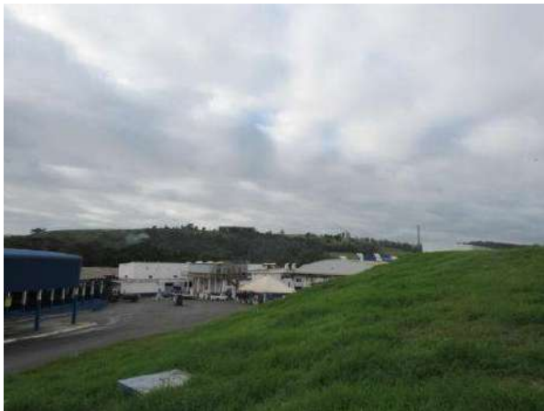
NR 999 - CLIMATIZAÇÃO FRIGORÍFICO DE IBIPORÃ ( 9 UN EXAUSTOR DE PAREDE ELM 900- 1, 8 UN INSUFLADOR DE
