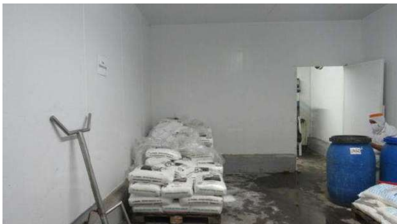
BLOCO INDUSTRIAL (MIÚDOS E TRIPARIA) Aspecto Interno
