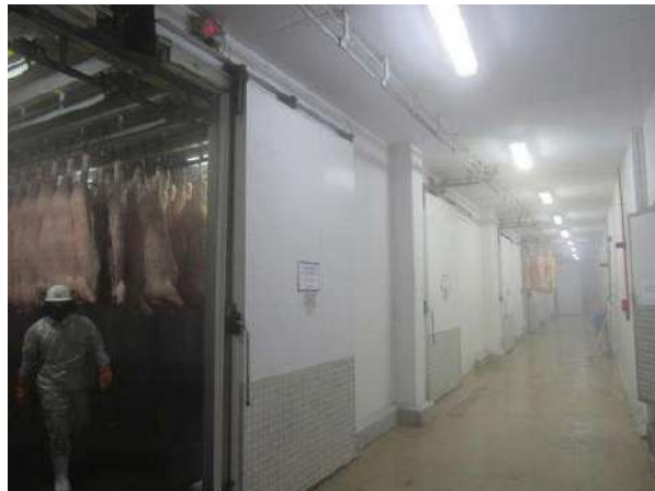
NR 999 - CÂMARA FRIA RESFRIAMENTO CARÇAÇA 5,8 x 14,3 x 5,1 M - 5
