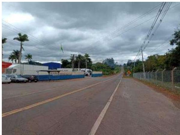
ACESSO Rodovia PR 090
