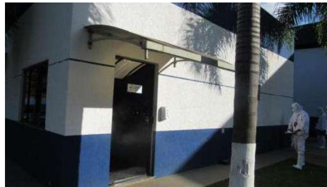
AMPLIAÇÃO DIF Aspecto Externo
