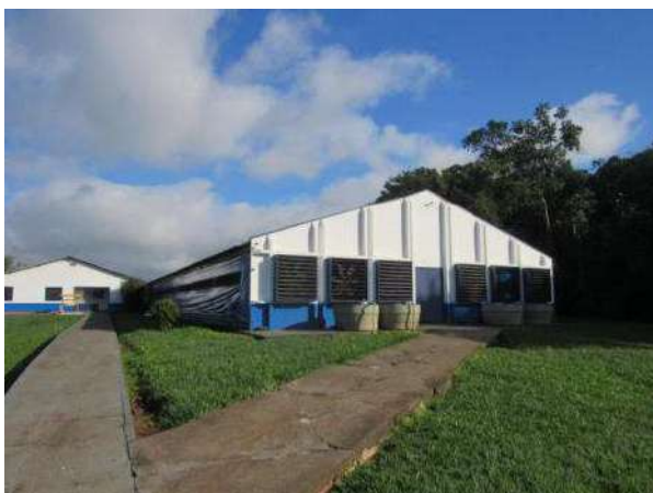
GALPÃO DE REPRODUTORES Aspecto Externo
