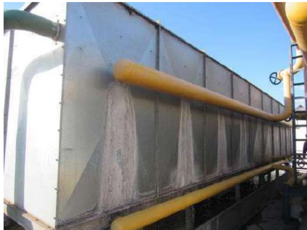
NR 999 - CONDENSADOR EVAPORATIVO
