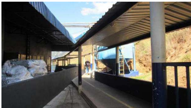
DESOSSA E TÚNEL (DEFUMADOR) Aspecto Externo
