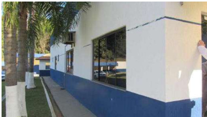
AMPLIAÇÃO DIF Aspecto Externo
