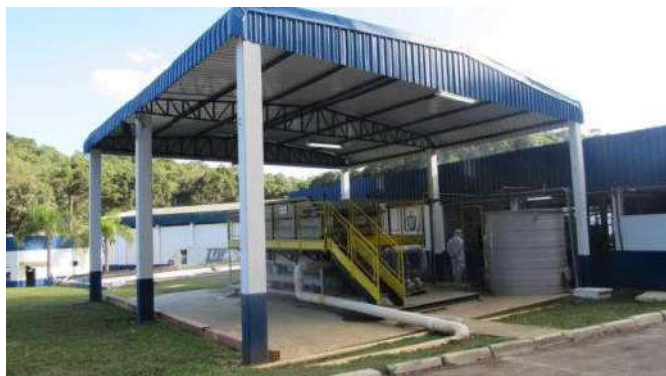
COBERTURA FLOTADOR / MISTURADOR 2 Aspecto Geral
