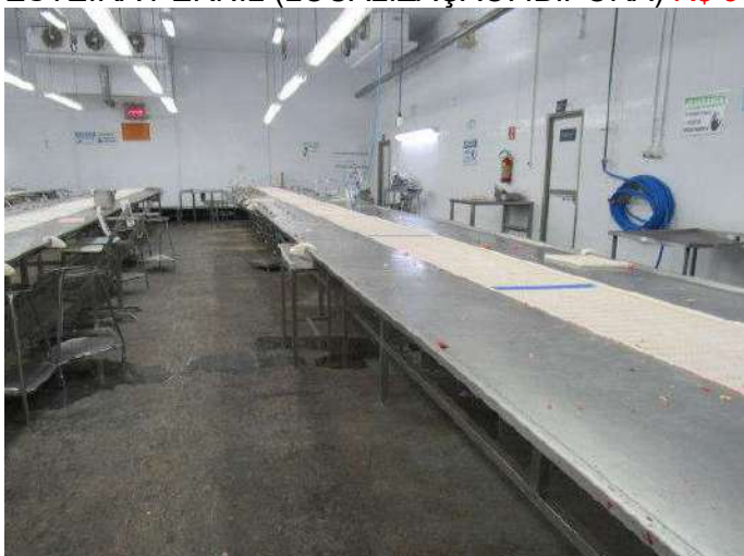
ESTEIRAS DE ENTRADA DO DEPILADOR (LOCALIZAÇÃO: BOCAIÚVA DO SUL) R$ 130.000,00
