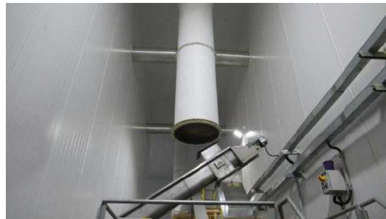
FÁBRICA DE BANHA Aspecto Interno
