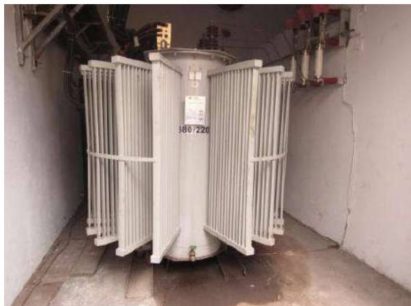
NR 999 - TRANSFORMADOR ÓLEO CAP. 2000 KVA COMEL
