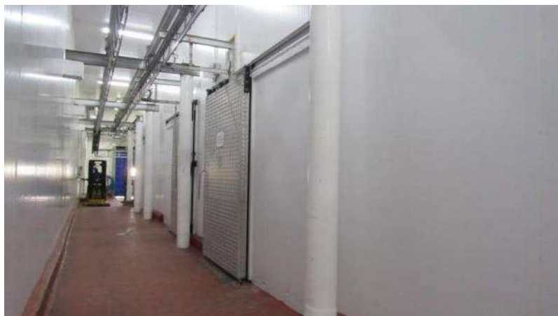
CÂMARA DE ESTOCAGEM Aspecto Interno
