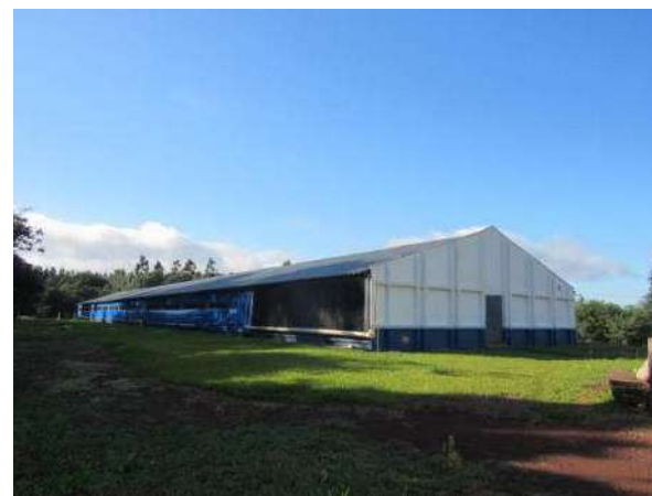
GALPÃO DE REPRODUTORES Aspecto Externo
