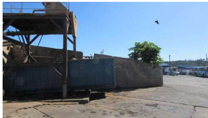
LAVADOR, SILO E PENERIA Aspecto Geral
