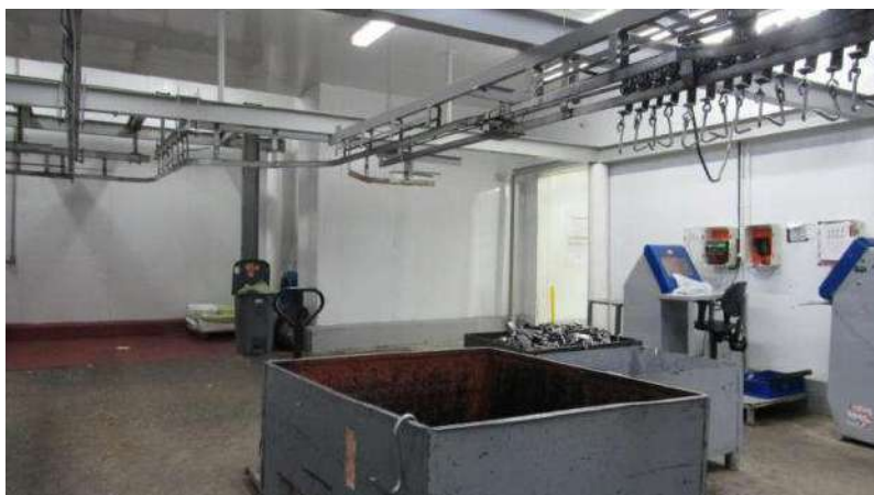
DESOSSA E TÚNEL Aspecto Interno
