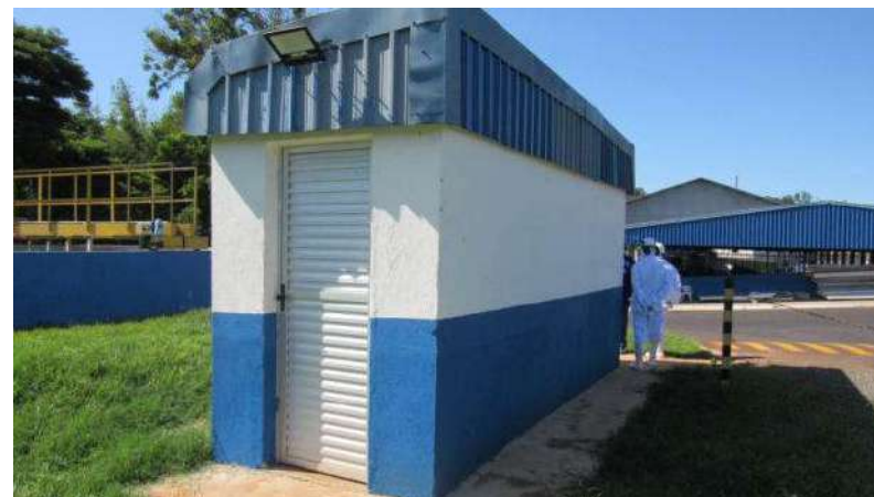
DECATADOR E POÇO ARTESIANO Aspecto Geral
