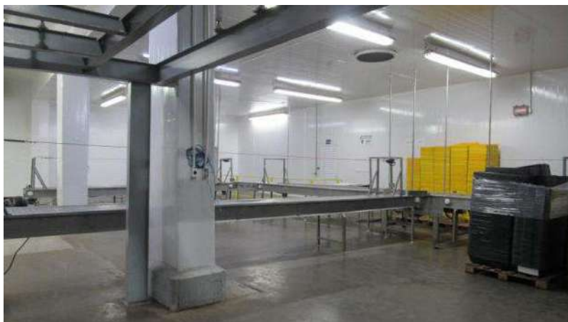
BLOCO INDUSTRIAL Aspecto Interno
