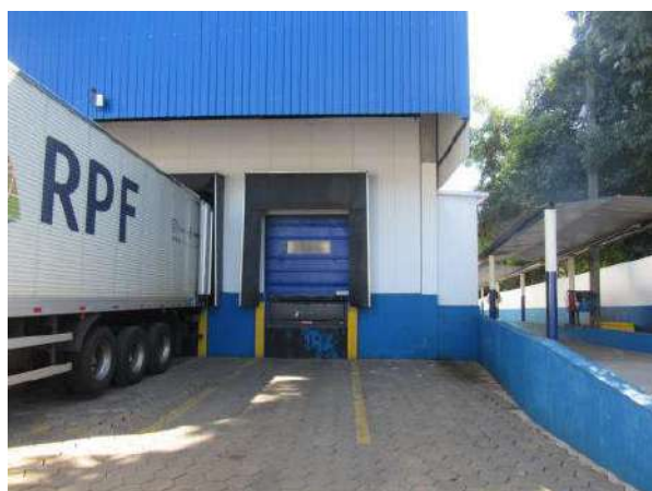
NR 999 - DOCA NIVELADORA COM PORTA AUTOMÁTICA RAYFLEX
