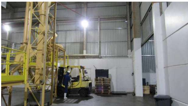
GRAXARIA Aspecto Interno
