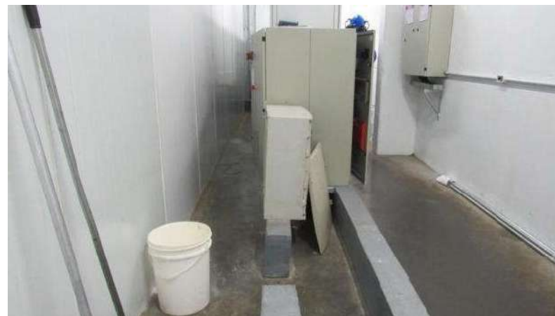
GRAXARIA Aspecto Interno
