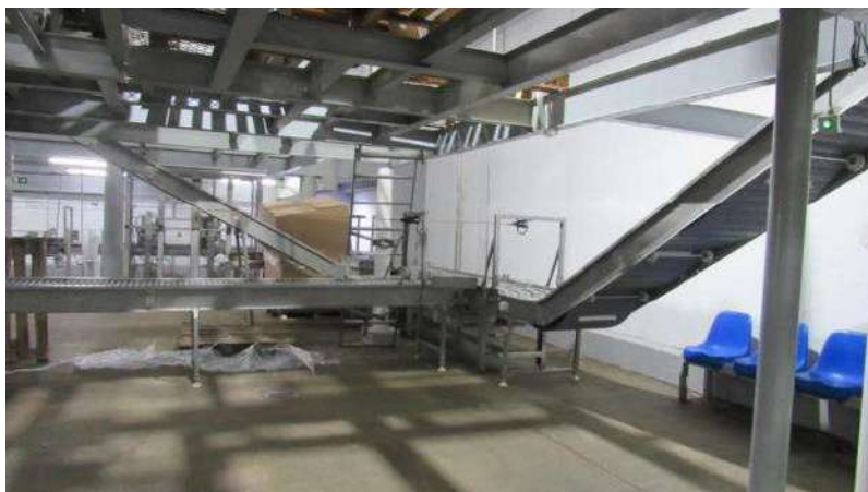
BLOCO INDUSTRIAL Aspecto Interno
