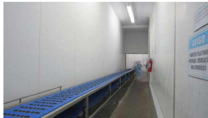
BLOCO INDUSTRIAL (MIÚDOS E TRIPARIA) Aspecto Interno
