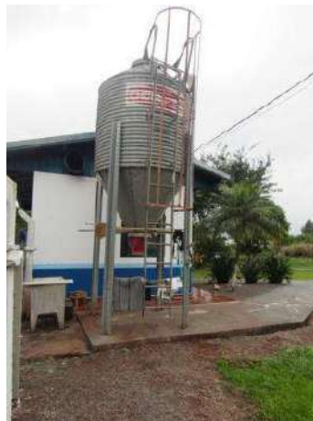
NR 999 - SILO ELEVADO DE RAÇÃO CAP. 4 T CHORE-TIME
