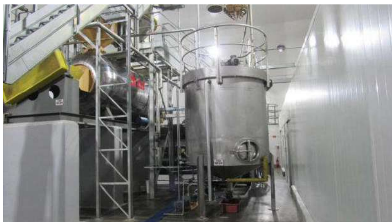
FÁBRICA DE BANHA Aspecto Interno
