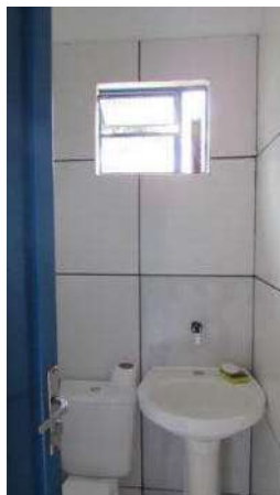
VESTIÁRIO Aspecto Interno
