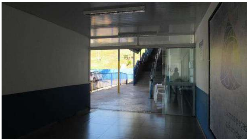
GUARITA Aspecto Interno
