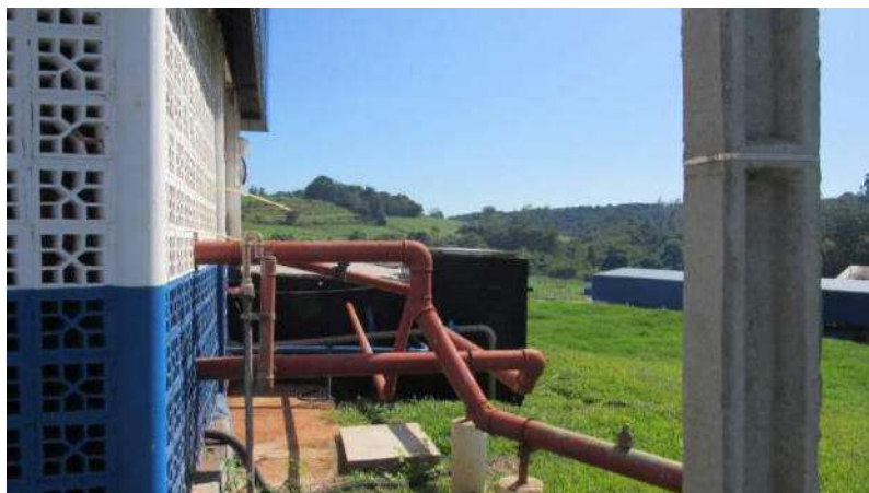
RESERVATÓRIO 600.000 L Aspecto Geral
