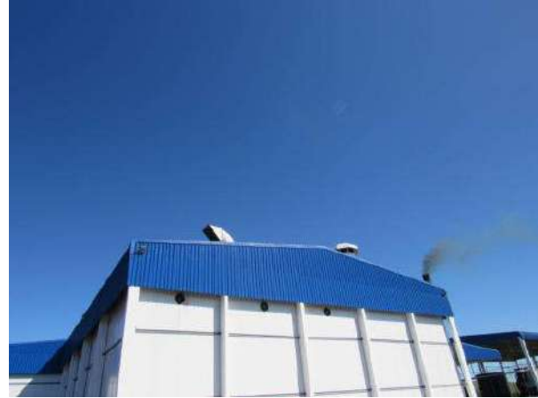
NR 999 - CLIMATIZAÇÃO DA GRAXARIA ( 6 UN EXAUSTOR ETM 900-2 E 6 UN INSULFLADOR 900- 2) MAXIVENT / COL
