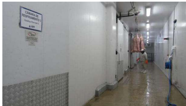
DESOSSA E TÚNEL Aspecto Interno
