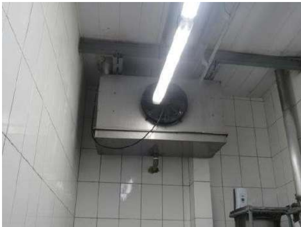
NR 999 - EVAPORADOR COM 1 VENTILADOR DE SOSSA SEQUESTRO NICOLA
