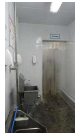
BLOCO INDUSTRIAL (MIÚDOS E TRIPARIA) Aspecto Interno
