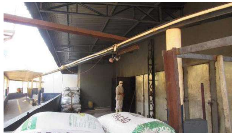
DESOSSA E TÚNEL (DEFUMADOR) Aspecto Externo
