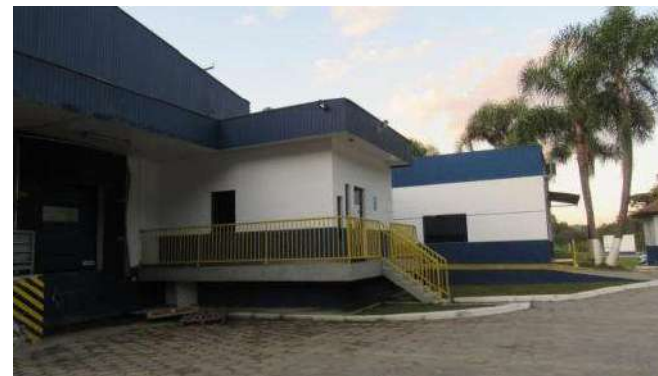
PINTURAS E REFORMAS Aspecto Geral
