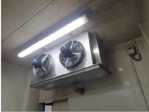
NR 999 - EVAPORADOR COM 2 VENTILADORES SALA DE CURA DEFUMADOS NICOLA
