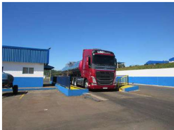
NR 200 - BALANÇA RODOVIÁRIA CAP. 80 T DIM. 18 X 3 M PÁTIO INTERNO DIGITRON
