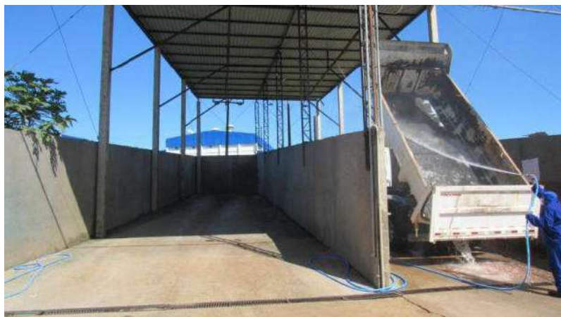
LAVADOR, SILO E PENERIA Aspecto Geral
